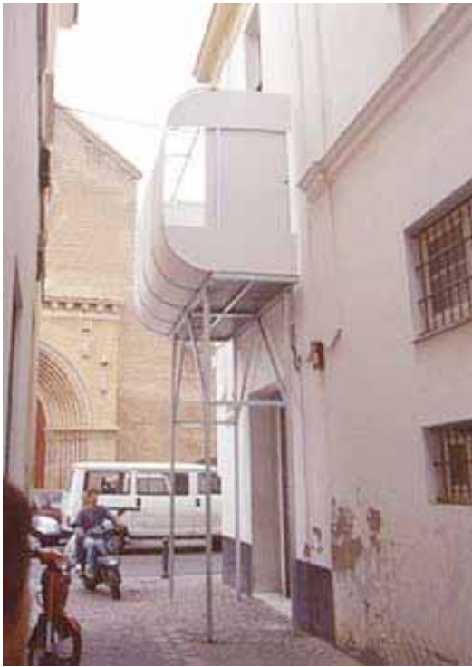
Ampliación de viviendas con andamios
